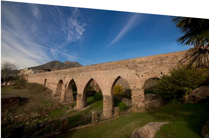
Sant Josep Aqueduct
