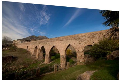
Sant Josep Aqueduct
