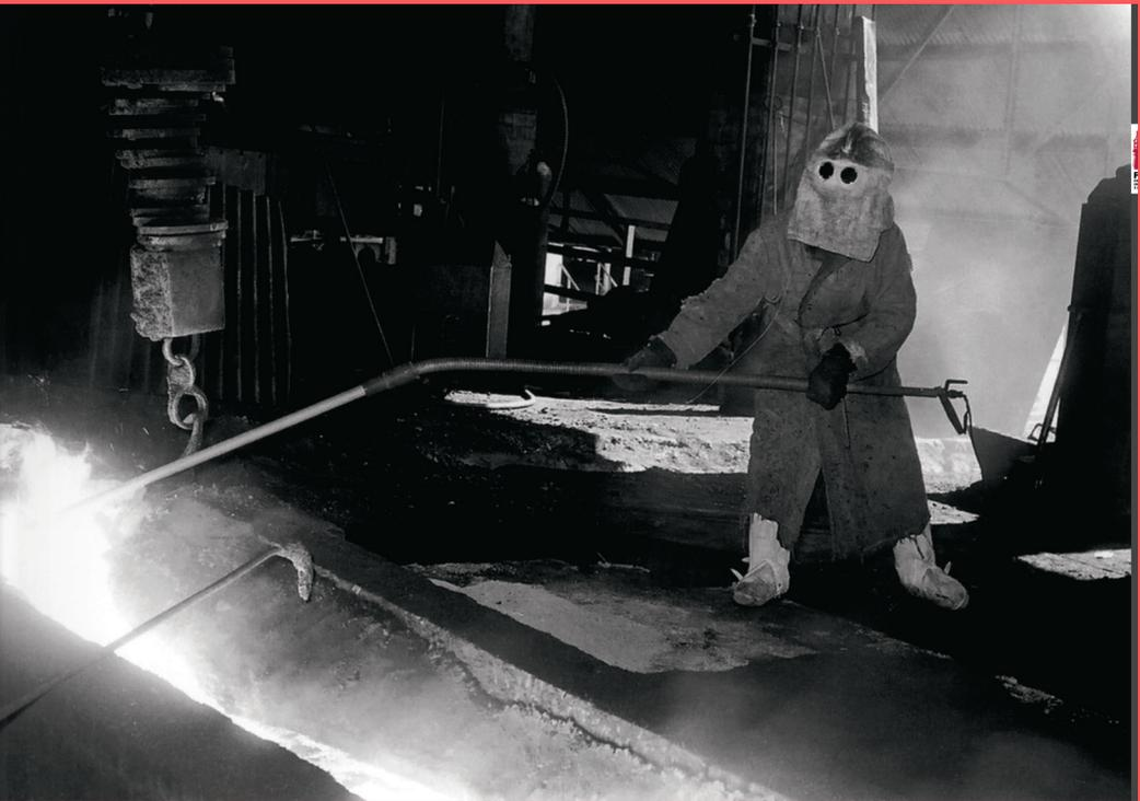
Toma de Temperatura del hierro fundido "arrabio" (1970)
