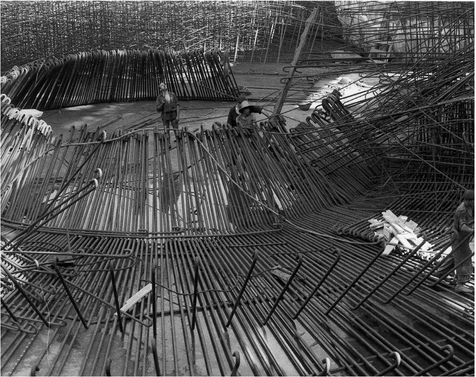
Construcción de la losa de anclaje del Horno Alto nº2. 1962
