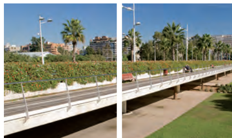
Le pont des Flores, esthétique et technique sur l'ancien lit du Turia.
